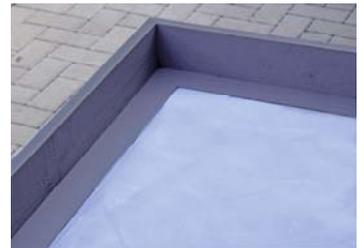
Am Rand ca. 5-10 cm von den Blenden zurückbleiben um eine spätere Vermischung von Flächen- und Blendenkleber zu vermeiden. (Eine gute Hilfe ist es, den Randabstand zuerst zu markieren) Der Kleber darf nur über 5°C verarbeitet werden.
